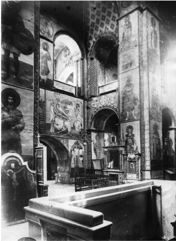
Рис. 16. Вигляд на середню кліть північної нави. Огородження приділа у верхній частині мають заокруглене завершення зі скляних рам для проникнення світла. Фото 1930-х рр.
