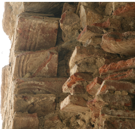
Рис. 46. Мурування з цегли-пальчатки. Храм Сурб Карапет (1570-ті рр.), р-н Мокс, турецька Вірменія. Фото надане Д.Д. Йолишиним
