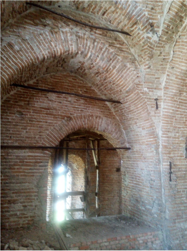
Рис. 32. Металеві скріплення та балки у муруваннях Спасо-Преображенської церкви (1757 р.) у Ніжині. Фото 2018 р.
