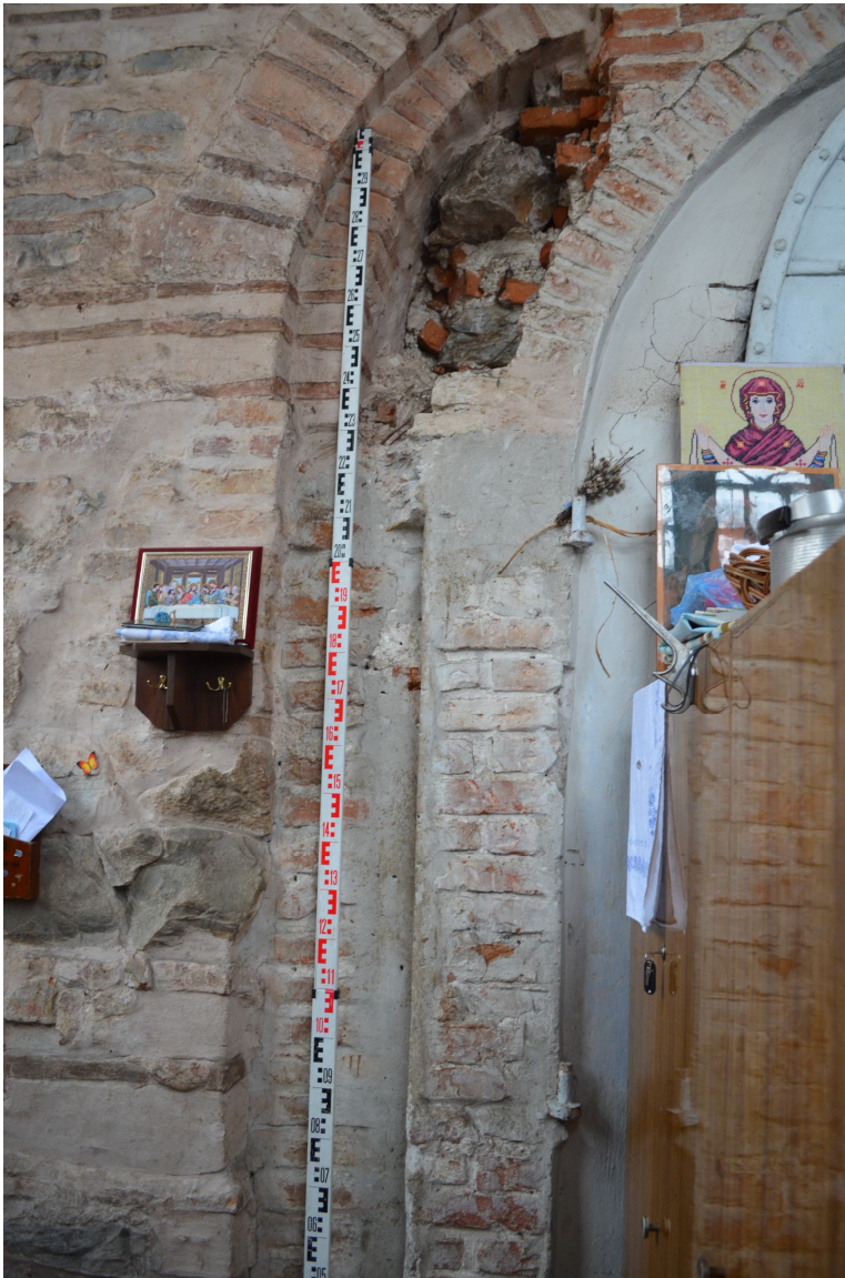
Рис. 22. Мурування XVII–XIX ст. в обрамленні північного порталу Спасо-Преображенського собору (початок XI ст.) в Чернігові. Фото 2014 р.
