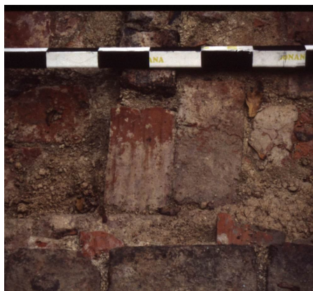
Рис. 47. Мурування з цегли-пальчатки. Шуваловський ганок Зимового палацу (1750-ті рр.) у Санкт-Петербурзі. Фото надане О.М. Йоанніссяном
