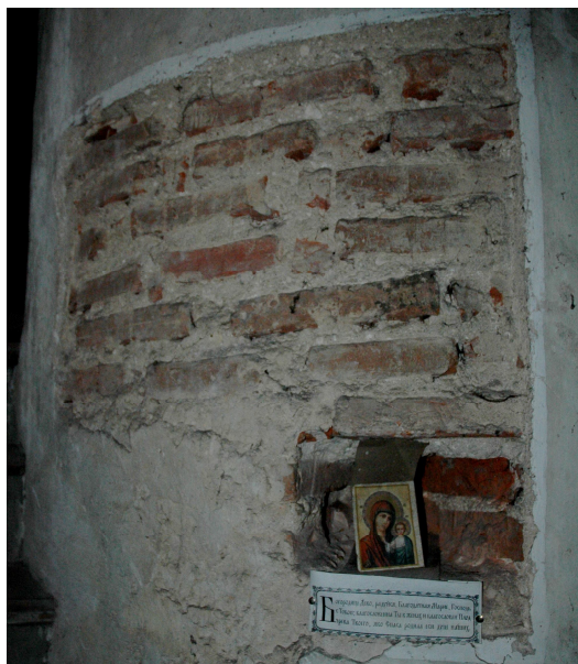
Рис. 43. Ремонтне мурування (XVII ст.) закругленої поверхні опорного стовпа сходової вежі Спасо-Преображенського собору в Чернігові. Фото 2012 р.
