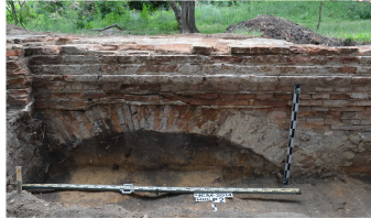
Рис. 31. Розвантажувальна арка в основі втраченої зовнішньої північної стіни Єлецького Свято-Успенського монастиря (XVIII ст.) (за матеріалами досліджень 2014 р.) ^
