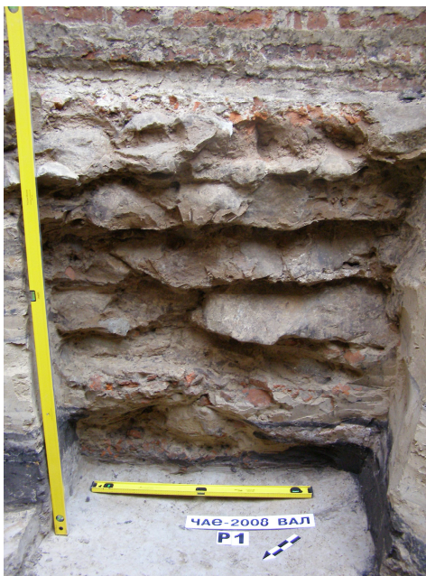
Рис. 30. Плитняк в основі фундаментів Чернігівського Колегіуму. Фото 2008 р.
