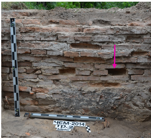
Рис. 33. Залишки стіни Єлецького Свято-Успенського монастиря (XVIII ст.). Стрілкою позначено гніздо від кріплення риштування. Фото 2014 р.
