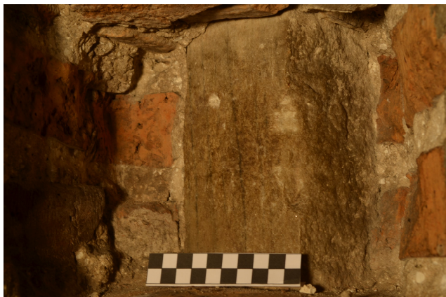
Рис. 27. Мармуровий бордюр з давньоруським графіті у ремонтному муруванні з цегли пальчатки (XVII ст.). Зондаж у південно-західній колоні Спасо-Преображенського собору в Чернігові. Фото 2014 р.
