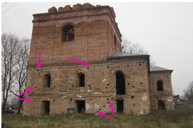
Рис. 34. Іллінська церква у Коропі (XVII ст. – ?). Стрілками позначено ряди гнізд від кріплення каркасу сходів та галереї. Фото 2017 р.
