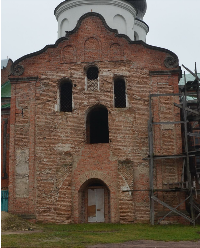
Рис. 23. Різномасштабні мурування та сліди примикання прибудов на фасаді Спасо-Преображенської церкви (1757 р.) у Ніжині. Фото 2017 р.
