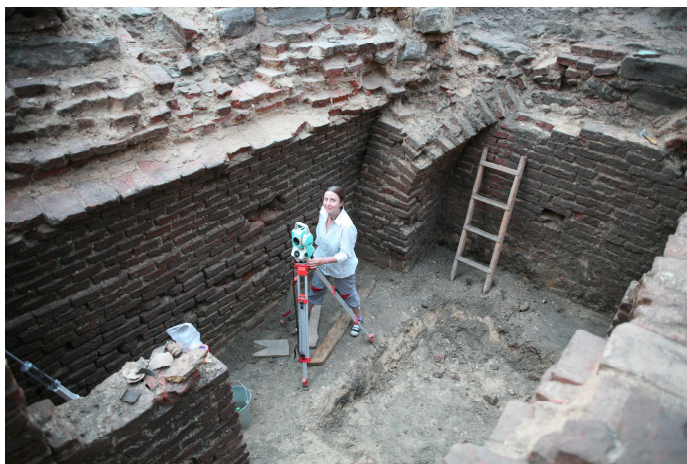
Рис. 15. Обмір крипти XVII ст. у північній прибудові Спасо-Преображенського собору в Чернігові із застосуванням тахіометру. Фото 2012 р.
