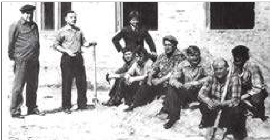
Реконструкція побутового корпусу АТП-24030. Початок 70-х років.
